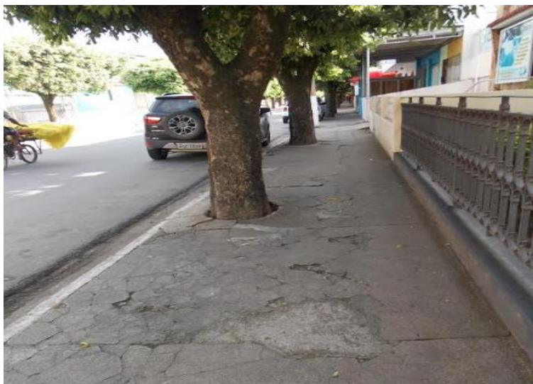
Fotografia 2 - Calçada que dá acesso ao Instituto
