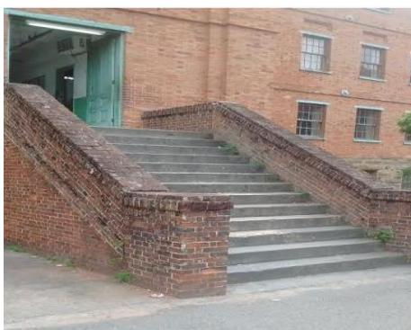
Fotografia 4 – Escada para acesso ao prédio
